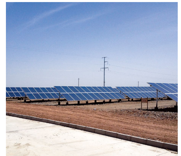
甘肃临泽50MWp并网光伏电站建筑项目
