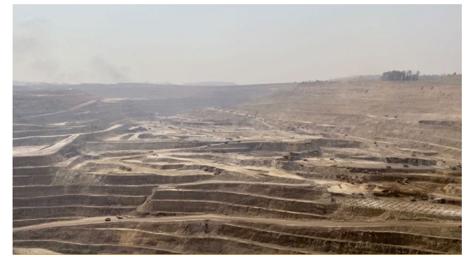
刚果(金)SICOMINES铜钴矿采剥项目
