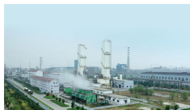
安徽铜陵有色40万吨铜冶炼工艺技术升级改造项目
