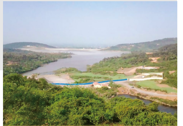
湖北中海油大峪口尾矿库项目
