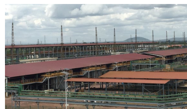
缅甸蒙育瓦莱比塘铜矿项目
