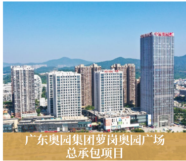
广东奥园集团萝岗奥园广场 总承包项目 Guangdong Aoyuan Group Luogang Aoyuan Plaza General Contracting Project
