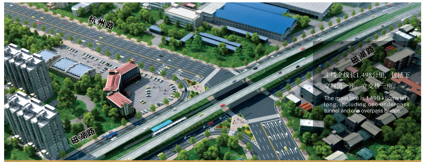
黄石现代有轨电车配套节点跨线桥项目
