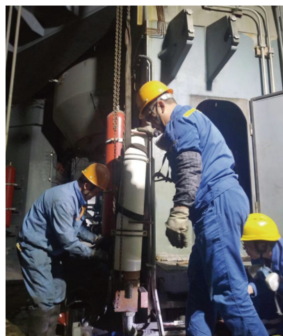
冰铜磨机检修 Matte mill repair
