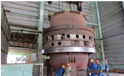
卡尔多炉炉体检修 Kaldor furnace body maintenance
