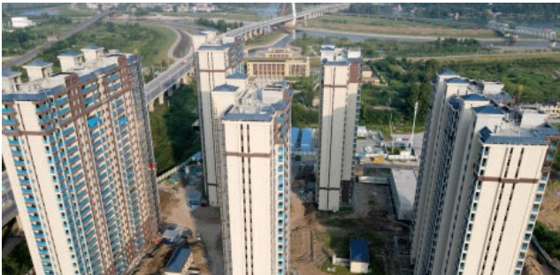
湖北黄石西塞山区还建楼项目EPC总承包项目
