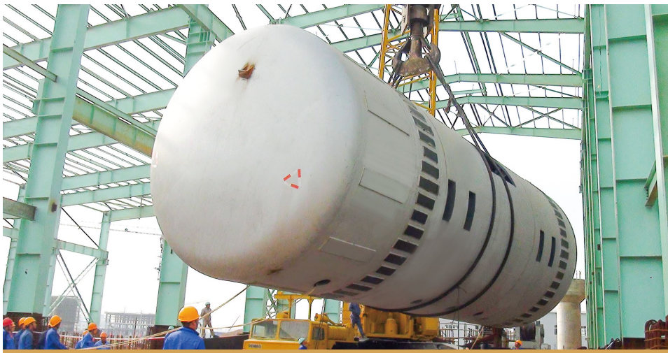
铜陵有色铜冶炼工艺技术升级改造阳极炉吊装
