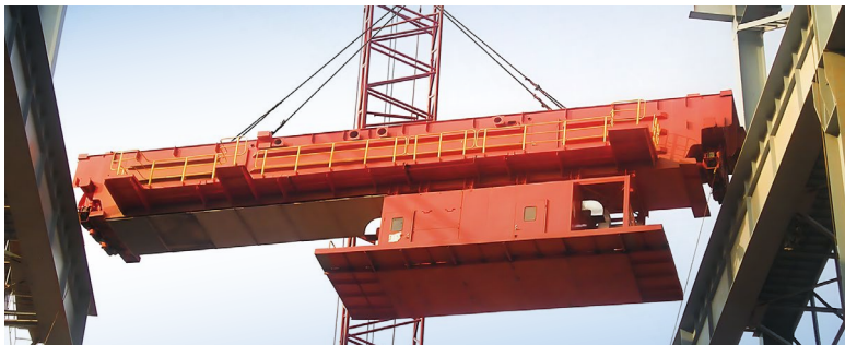
江西新余钢厂360吨行车吊装
