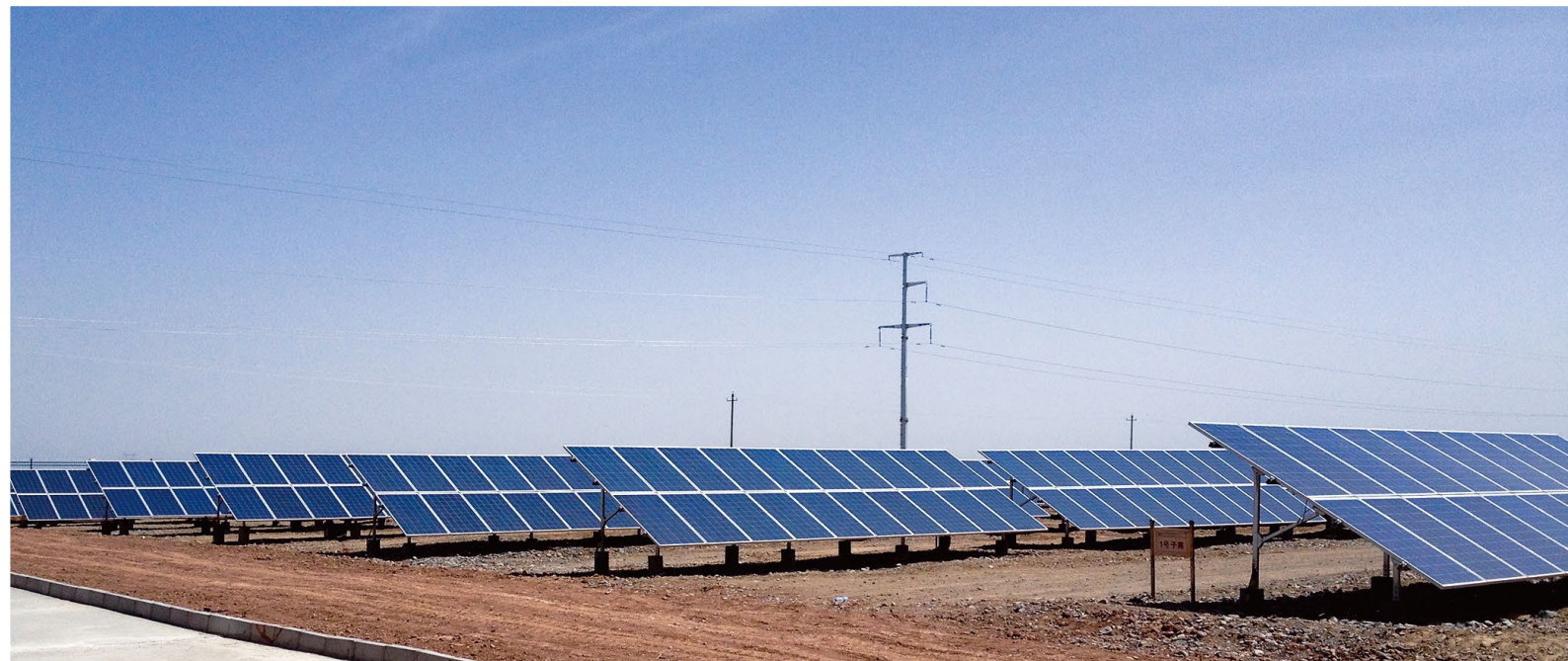
甘肃临泽50MWp并网光伏电站建筑项目
