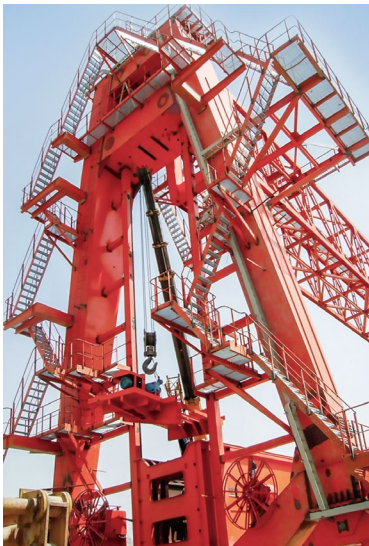
山西柳林电厂斗轮机柔性端安装
